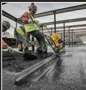
REGLA VIBRADORA
