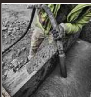
VIBRADOR DE HORMIGÓN
